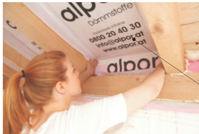
alpor Granulatfolie (diffusionsoffener Rieselschutz)
