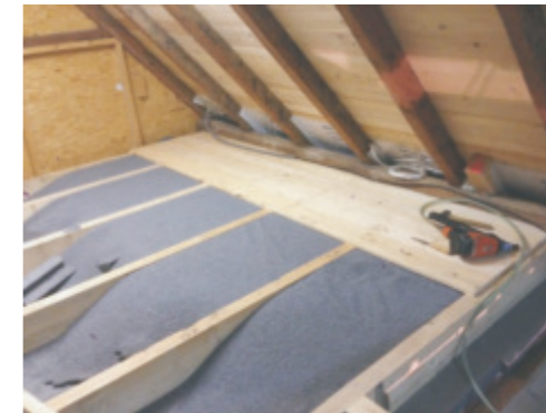
Holzschalung, Pressspanplatten, Fermacell keine OSB-Platten (die Abdeckung muss diffusionsoffen sein)
